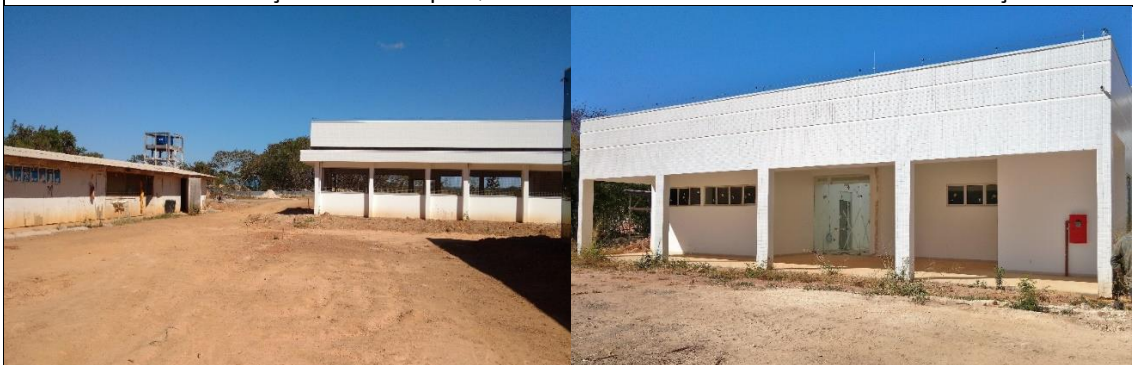
Vista do Bloco de Apoio aos quarentenários e instalações provisórias necessárias ao armazenamento de materiais e escritório da empresa contratada.
