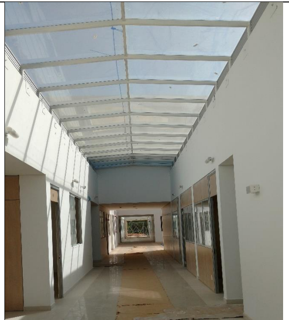
Telhas transparentes e mais elevadas, com o intuito de diminuir a necessidade de luz artificial e de manter o calor mais distante das instalações.
