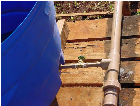
FIGURA 25B - Ligação da caixa de fertirrigação direto na sucção da bomba
