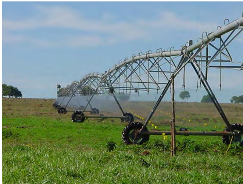
FIGURA 29 - Avaliação de um Pivô recém instalado.
