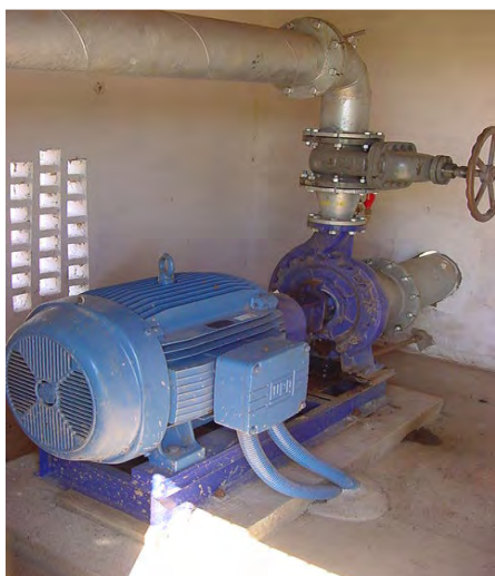
FIGURA 6 - Detalhe de um conjunto motobomba e da casa de bomba.
