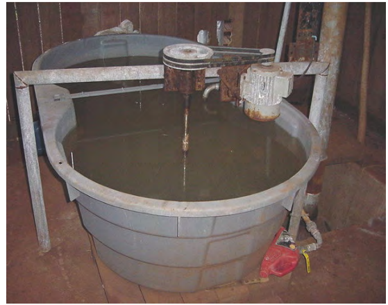
FIGURA 25C - Detalhe da montagem do agitador da caixa de fertirrigação
