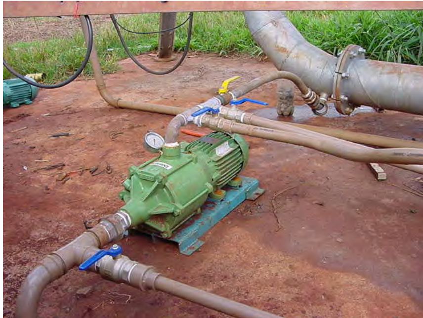
FIGURA 22 - Bomba centrífuga de multiestágios injetando fertilizante.
