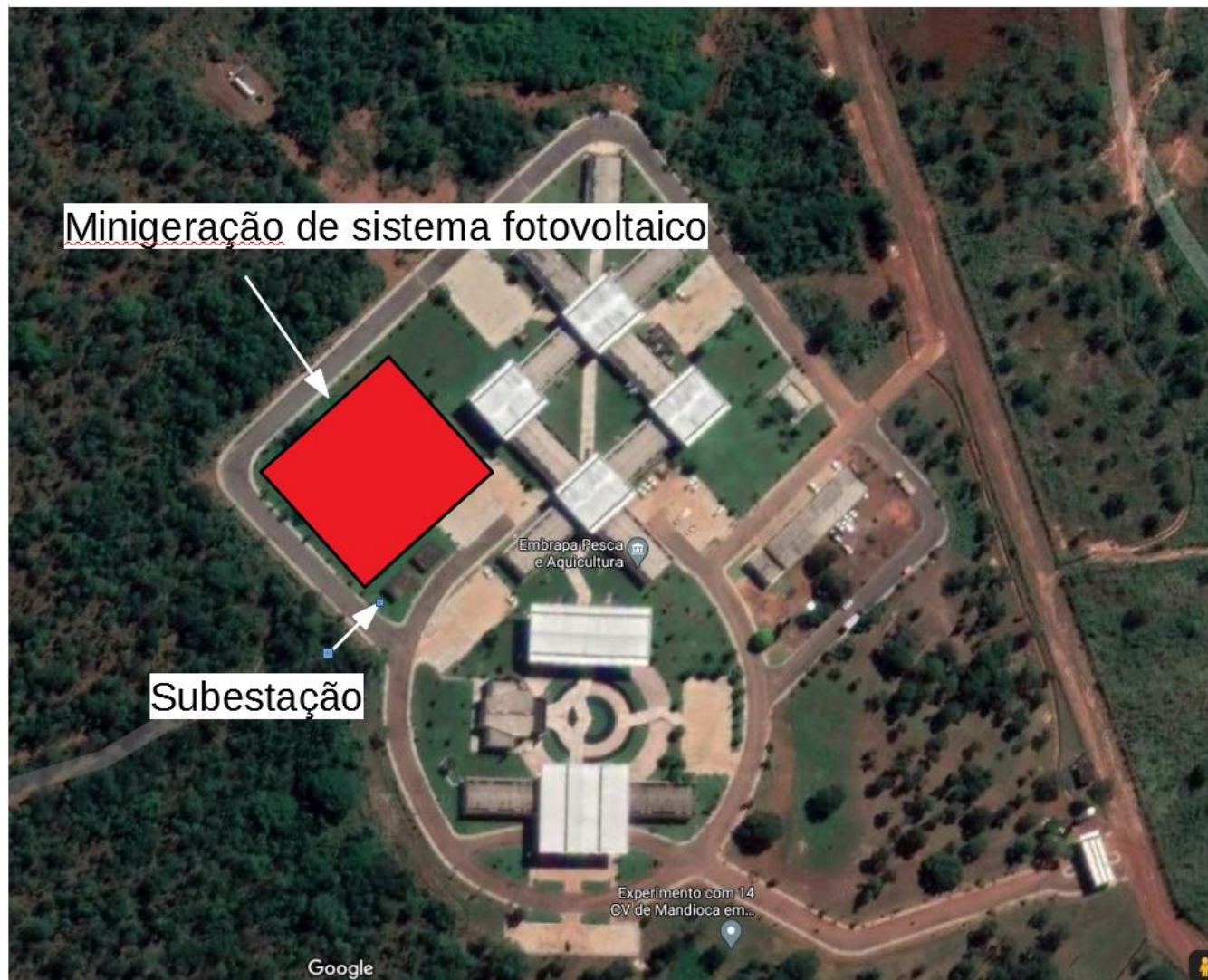
Ilustração 1 - Localização dos módulos fotovoltaicos que compreenderão a implantação de 558 painéis solares na Embrapa Pesca e Aquicultura - Sede.
